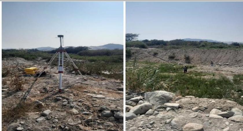
FIGURA N°01: TRAMO CRÍTICO EN EL RÍO HUAMANZANA, SECTOR SAN CARLOS Y LAS MERCEDES. SE INICIARON LOS TRABAJOS DE LEVANTAMIENTO TOPOGRÁFICO CON EL EQUIPO DE GPS DIFERENCIA, TOMANDO COMO BM Y PUNTO DE REFERENCIA, TAL CUAL SE MUESTRA EN LA IMAGEN. SE VISUALIZA EL ESTADO SITUACIONAL DEL TRAMO EN ESTUDIO, EVIDENCIANDO ASÍ LA CONTINUIDAD DE TRABAJOS REALIZADOS CON ANTERIORIDAD.
